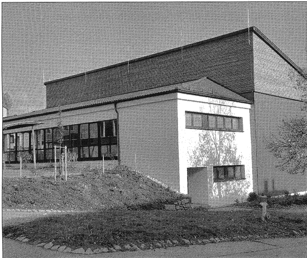
Gelungene Sanierung dank Konjunkturpaket II: die Nabburger Volksschule.
